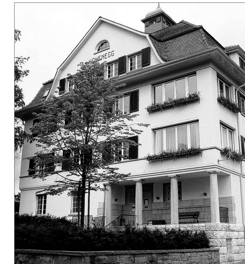
Zeitintensive und aufwändige Renovation: Der neue Verputz und die Farbe am Verwaltungsgebäude der Hohenegg sind gleich aufgebaut wie vor 100 Jahren. (zvg)
